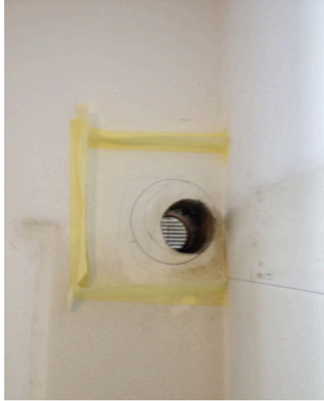
Markierung neue Bohrposition 162 mm
