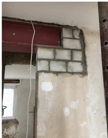
Neues Auflagepolster Stahlträger Rostschutz Grundiert und Verbolzt
