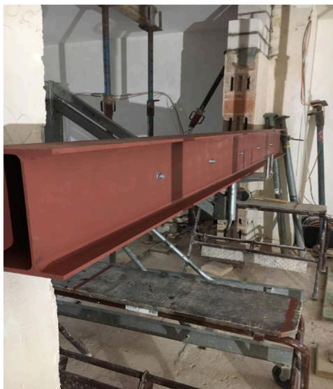
Neues Auflagepolster Stahlträger Rostschutz Grundiert und Verbolzt
