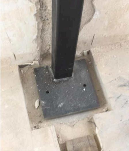
Stützen Fußpunkte verankert und mit Quellvergussmörtel verfüllt
