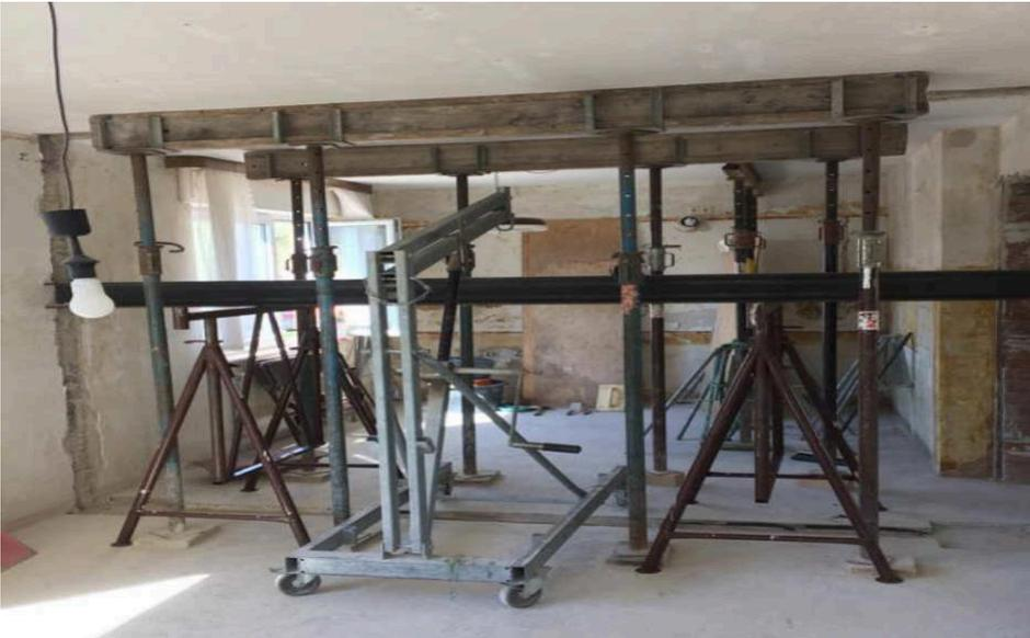
Montage Decken-Stahlträger mit Einsatz Kran/Lift
