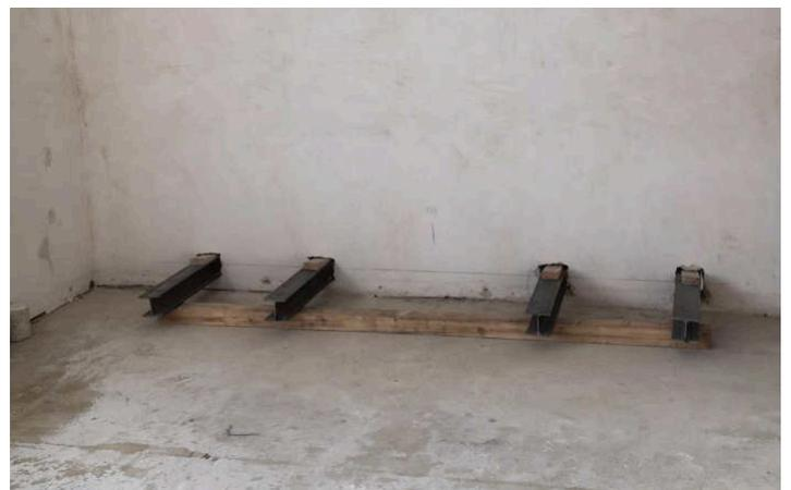
Notabstützung der Obergeschoss Wand 4 x HE100A Quer/Steckriegel in OG Wand
