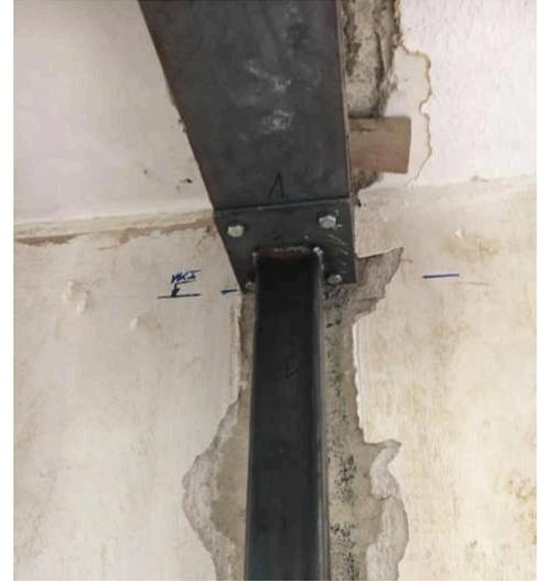
Stütze mit Sturz-Träger Verschraubt
